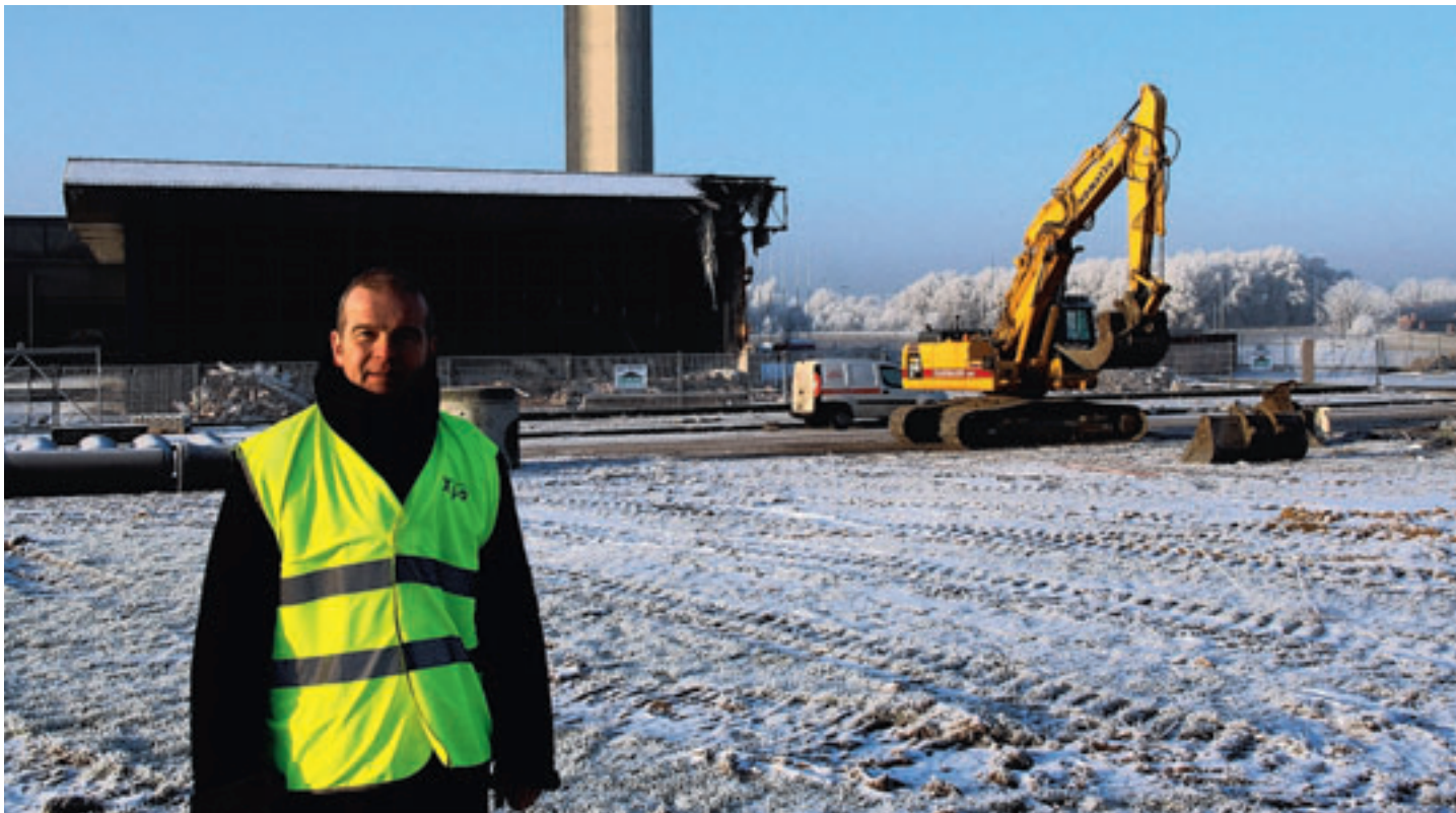
Joost Baert is tevreden dat de sloop van Kortrijk Xpo begonnen is. Foto JVK
