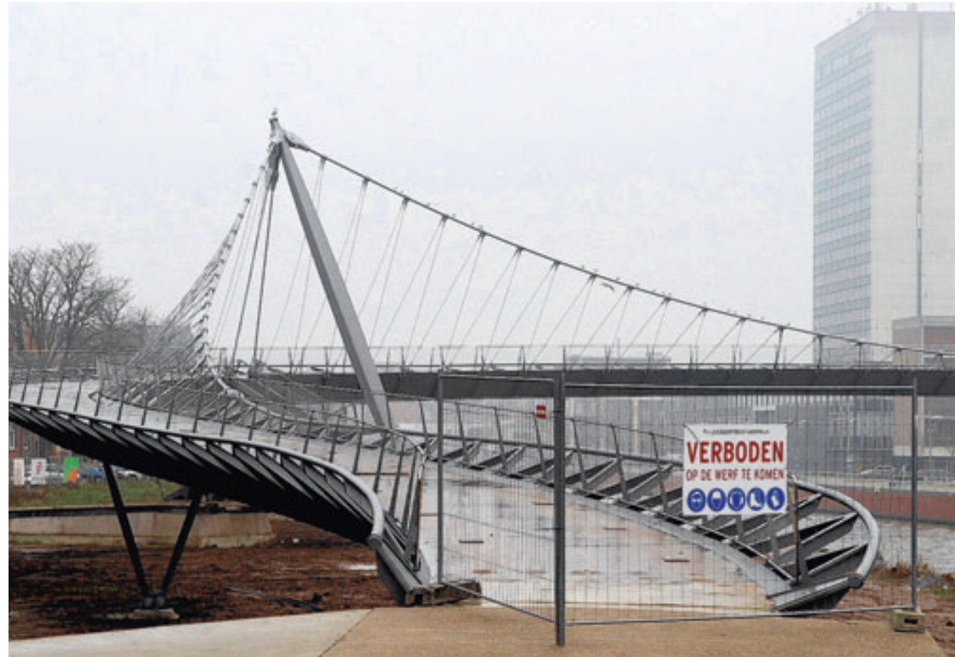
De opening van de collegebrug is uitgesteld door stabiliteitsproblemen. Foto JVK
