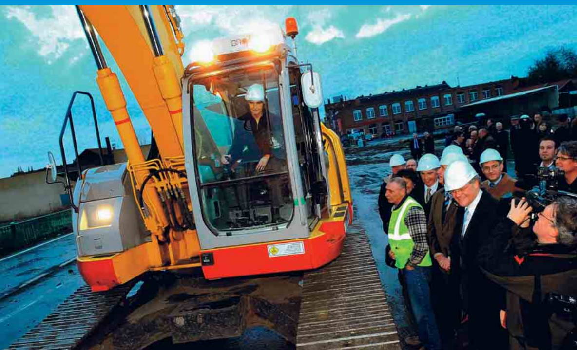
Minister Hilde Crevits mocht met een kraan de eerste steen afbreken van de Noordbrug.
