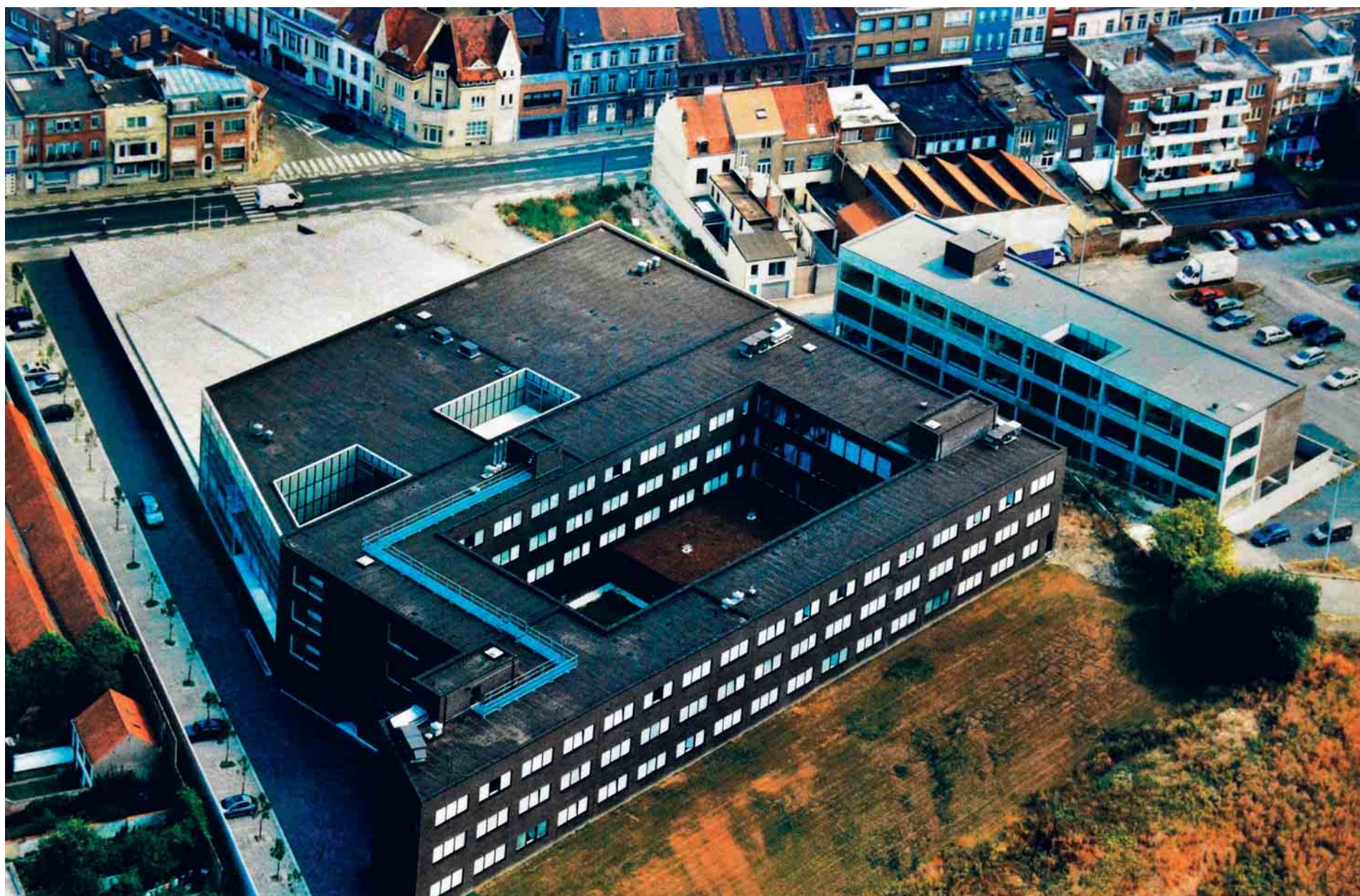
Achter het zwarte gebouw, Rechtbank II zoals het genoemd wordt, komt op de groene zone het nieuwe gerechtsgebouw dat de 'Oude Dame' in de Burgemeester Nolfstraat definitief moet vervangen. Rechts boven ook het Kortrijkse justitiehuis. © phk
