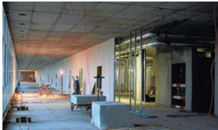
Arbeiders plaatsen hangwanden in de nieuwbouw. Foto JVK
