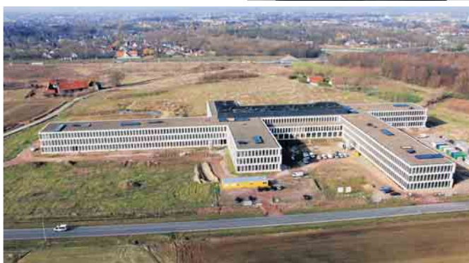
De nieuwe campus langs de Kennedylaan.
