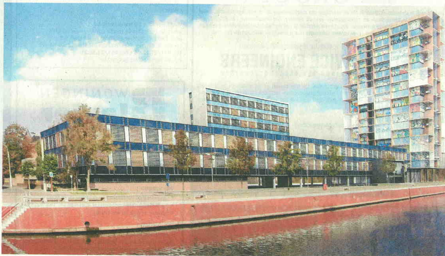
De Diksmuidekaai na 2008. De bestaande toren wordt gedeeltelijk gesloopt. Rechts komt een 60 meter hoge toren met 48 luxeflats. Foto Anckaert
